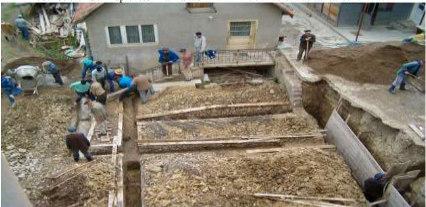
54. A lépcső és a garáj építése 2004 - Faze ale constcției, scările și garajul
