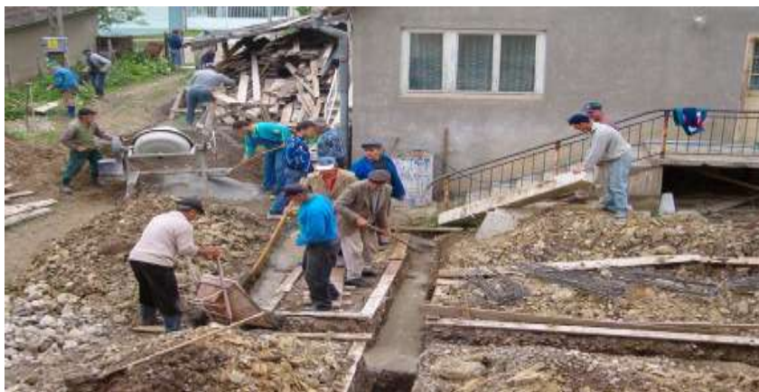
55. A lőpcső és a garáj építése 2004 - Faze ale constcției, scările și garajul
